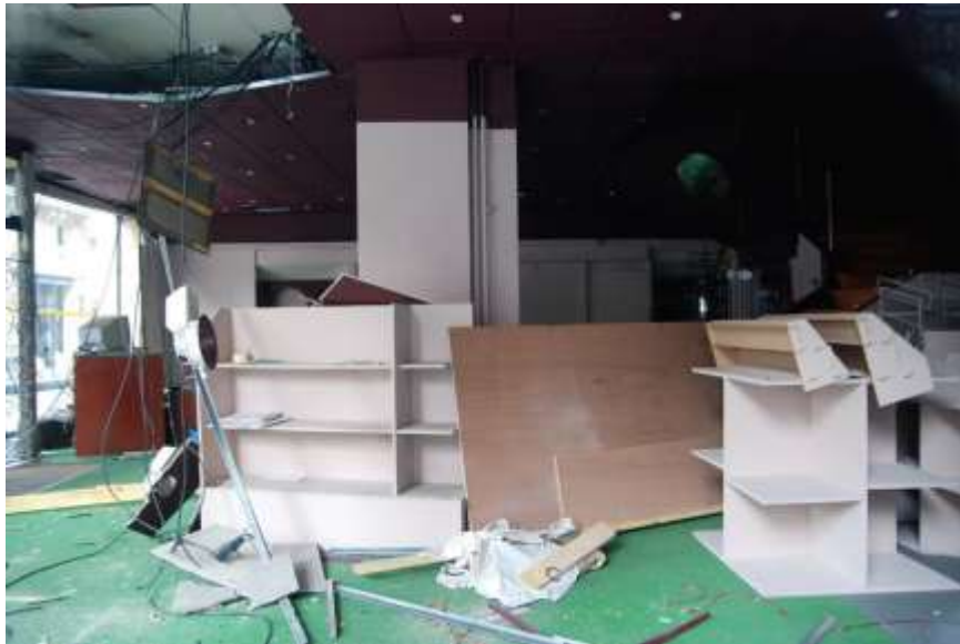
Rue Ravez, Bordeaux, 02 septembre 2009
