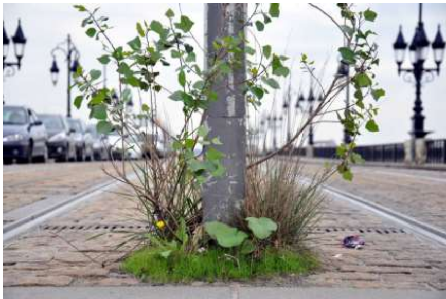
Pont de Pierre, Bordeaux, 18 octobre 2012
