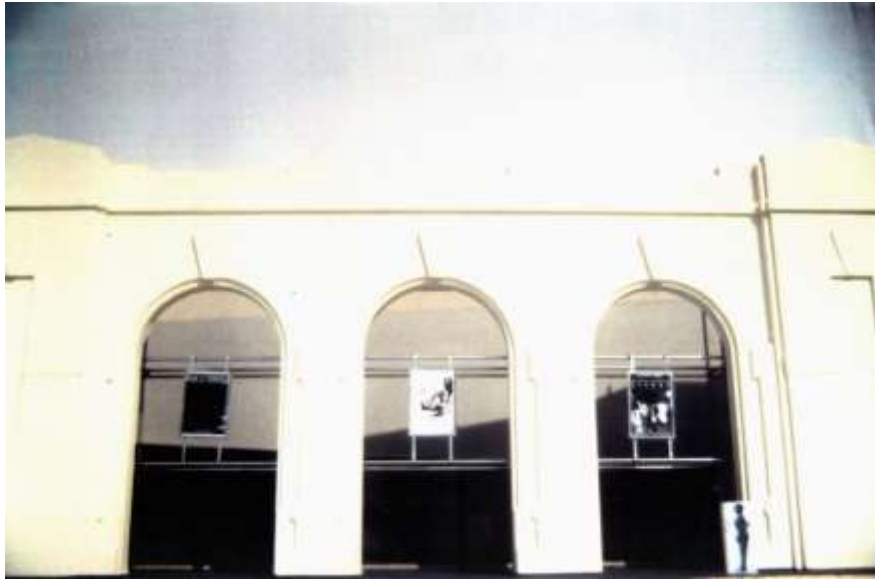
Cinéma Union, rue des coopérateurs, Limoges, 1997
